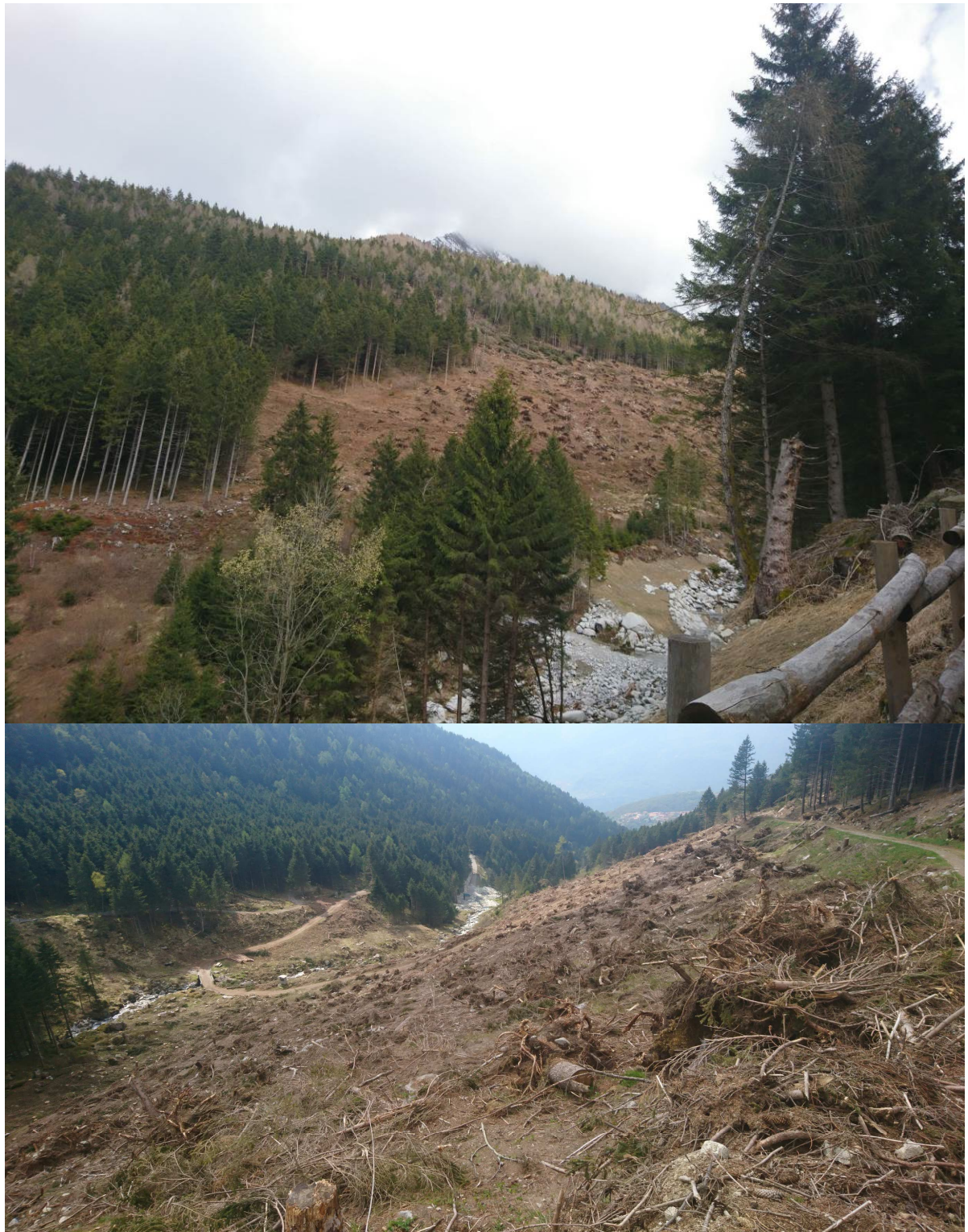
Cimbergo: aree oggetto di bonifica in località Ponte del Sergio lungo la Valle del Tredenus (2019)
