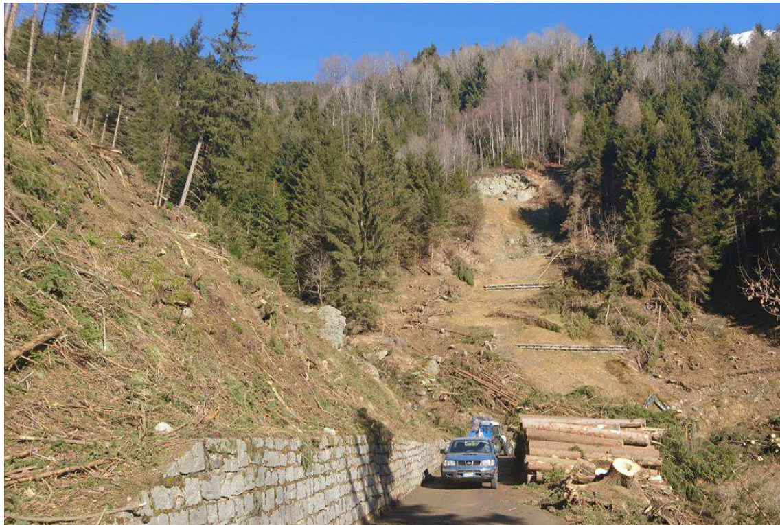
Fig. 22 - SAVIORE DELL'ADAMELLO: esbosco con verricello adiacente alla viabilità forestale a Fabrezza (2019)
