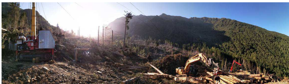
Fig. 31 - SONICO: cantiere forestale in Val Malga (2019)
