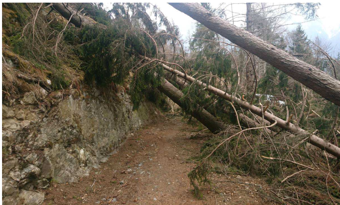
Fig. 11 - VIONE: viabilità forestale interrotta dal crollo di alberi ai Prati Alti (2018)
