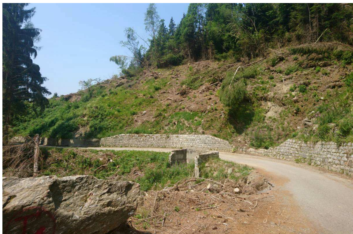
Fig. 41 - SAVIORE DELL'ADAMELLO: idrosemina lungo la strada di Fabrezza (2019)
